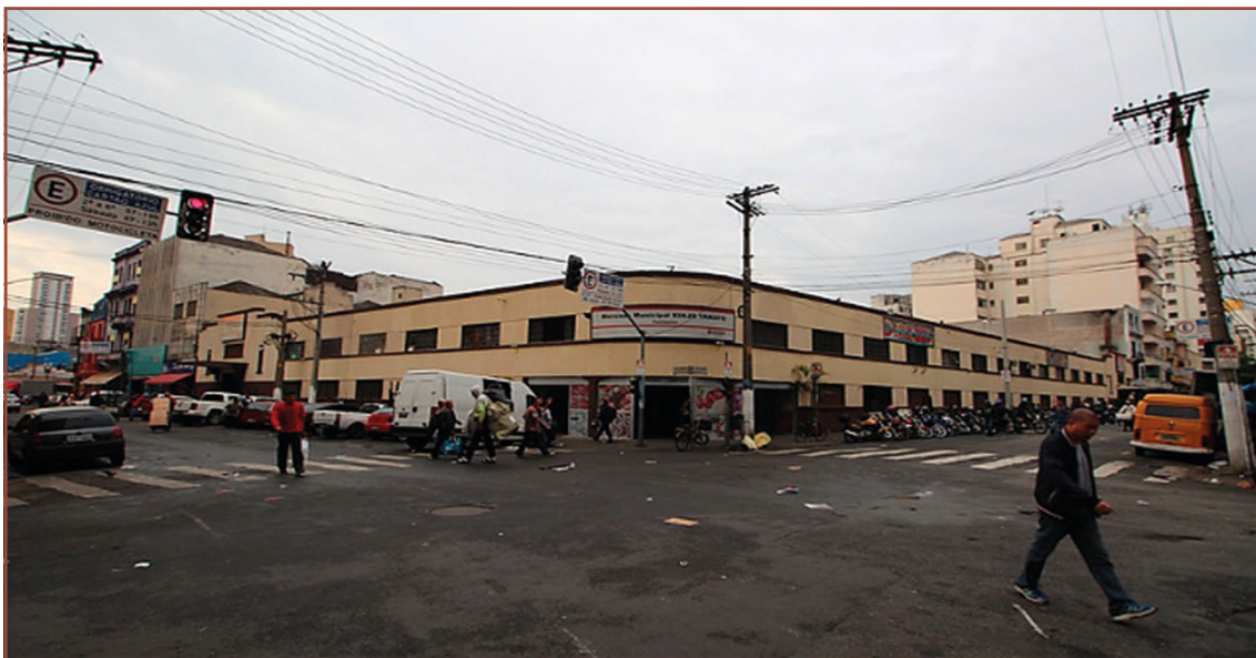
Figura 9 – Fachada do Mercado Kinjo Yamato, entrada no cruzamento das ruas Carlos de Sousa Nazaré e Barão de Duprat
